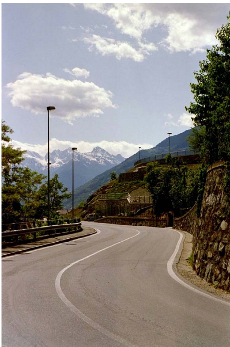
Photo 17: le ru Baudin sous la route qui mène à l'hôpital régional
