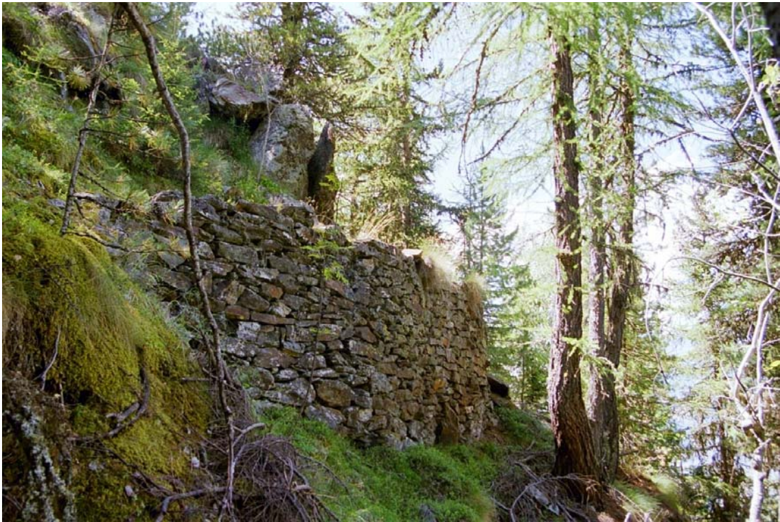
Photo 27: mur en pierres sèches le long de l'ancien canal
